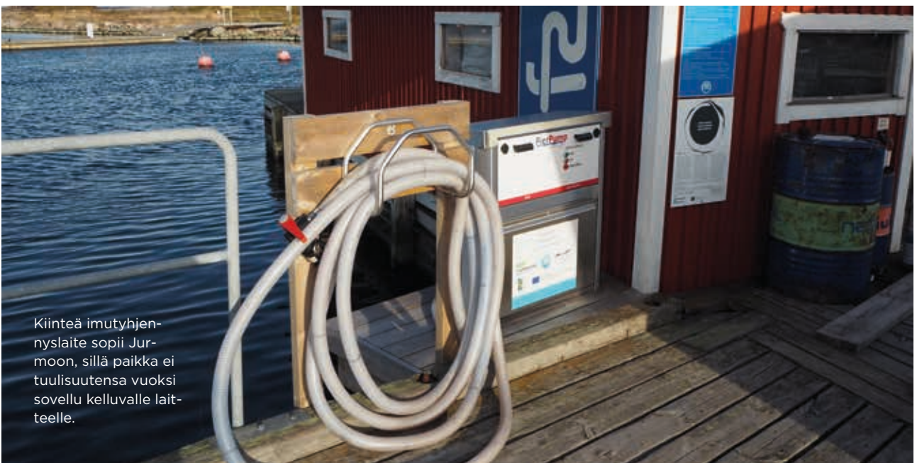
PSS ry:llä on yhteensä noin 30 kelluvaa imutyhjennyslaitetta sijoitettuina eri vesistöalueille. Yhteen kuvassa näkyvään imutyhjennyslaitteeseen mahtuu noin kuusi kuutiota käymäläjättevettä.
