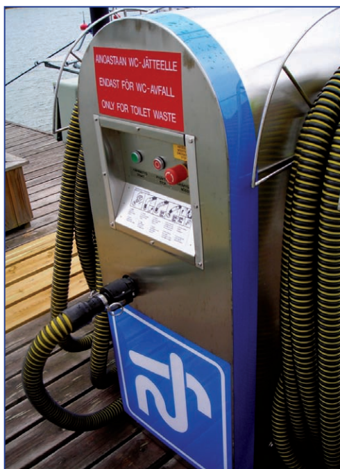
Laiturille asennettu imutyhjennyslaitteisto.
