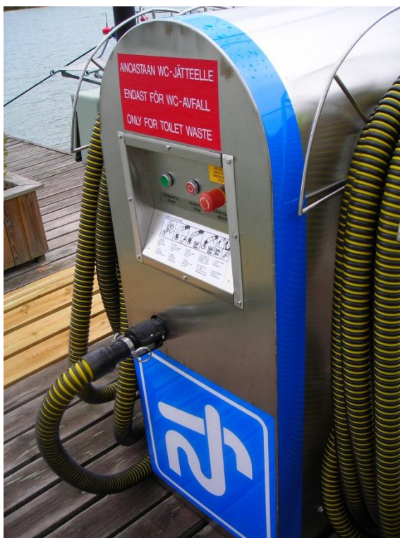
Laiturille asennettu imutyhjennyslaitteisto.
